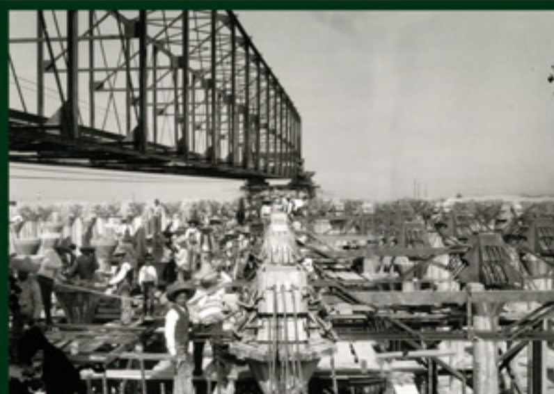
Autor no identificado, Trabajadores realizando las obras hidráulicas para el D.F., ca. 1909 (502230) CONACULTA. SINAFO.FN. MEXICO.
